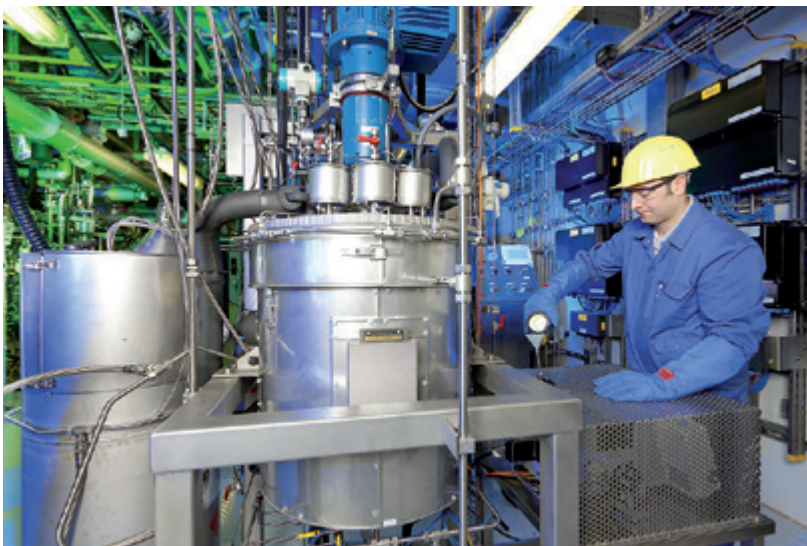
Abb. 6: Fertiggestellte Mini-Plant- Anlage für die Produktion von \text{CO}_2 -haltigen Polyolen
